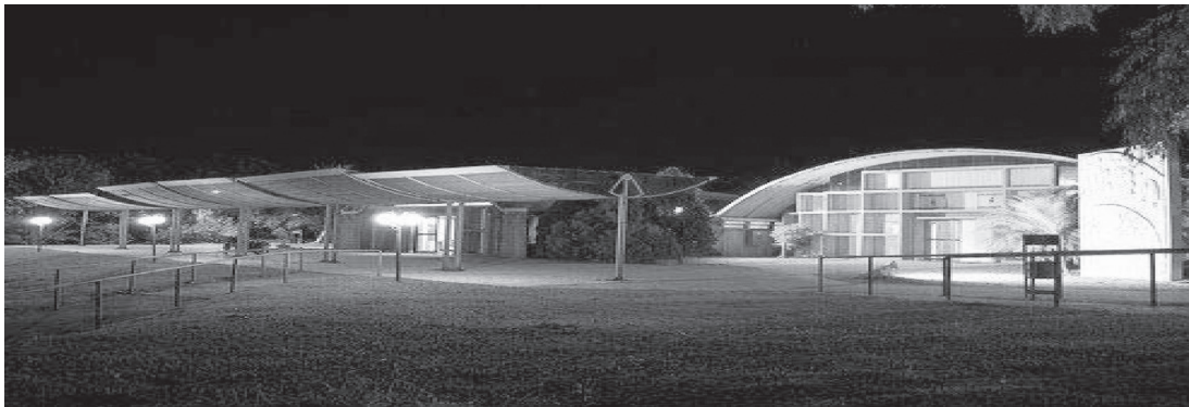
FIGURA 6.9 – FACHADA DA CASA DO LAGO
