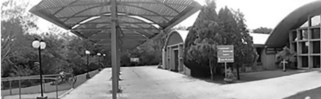
FIGURA 6.8 – ENTRADA PRINCIPAL E DA SALA MULTIUSO - CASA DO LAGO
